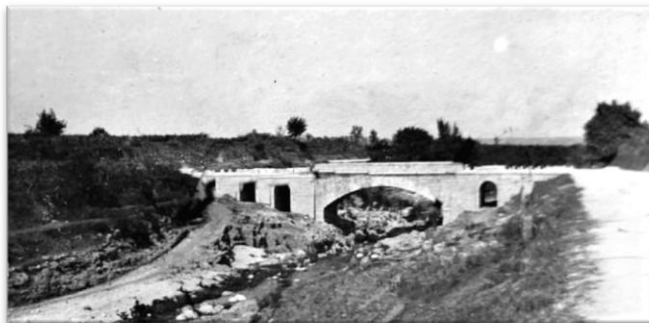
Imagen del puente de Agres o de Cañes , construido a finales del siglo XIX, en el que todavía no aparece el Batanet .
