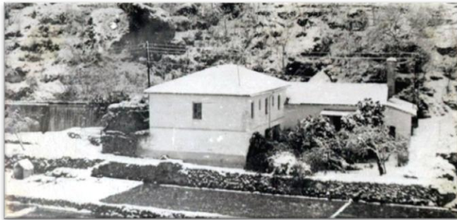
Central eléctrica de Colomer y vivienda. Foto archivo José Izquierdo.
