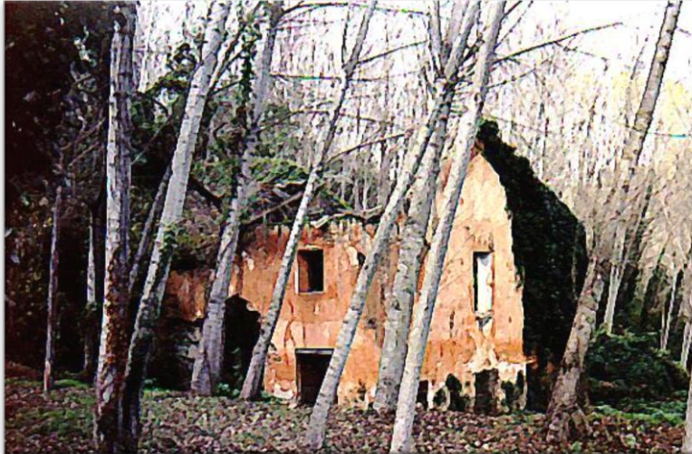
Central eléctrica de la Compañía Trenor meses antes de su desaparición en la década de los noventa del siglo XX. Foto José Izquierdo.
