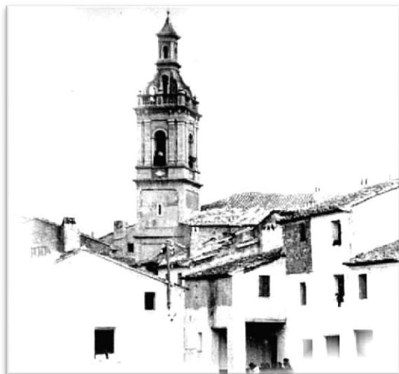
Panorámica del actual campanario y Portal de San Roque.
