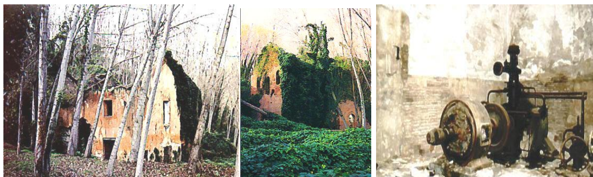
Centrales eléctricas de los Trenor y Cia - Fabrica del Reino -Turbina del Salto . Fotos José Izquierdo
