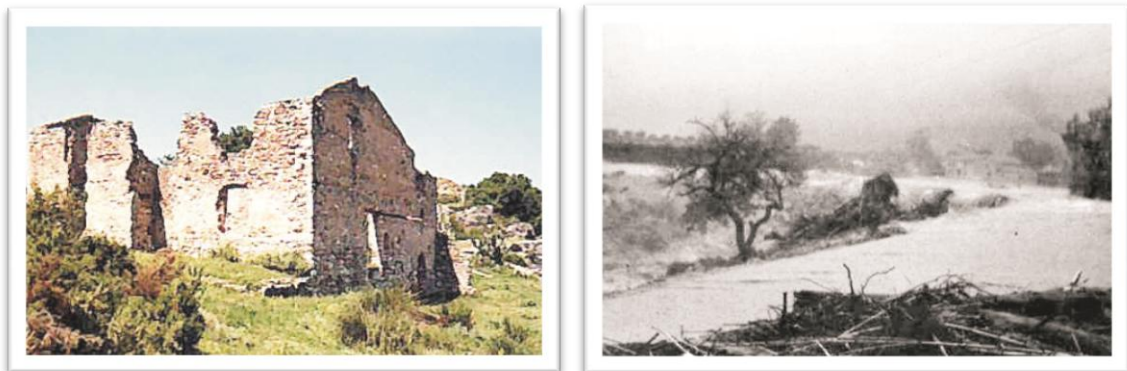
Ruinas del tinte de A. Fuster en la F. de Marzo y rambla del puente de Cañes en la riada de 1982.
