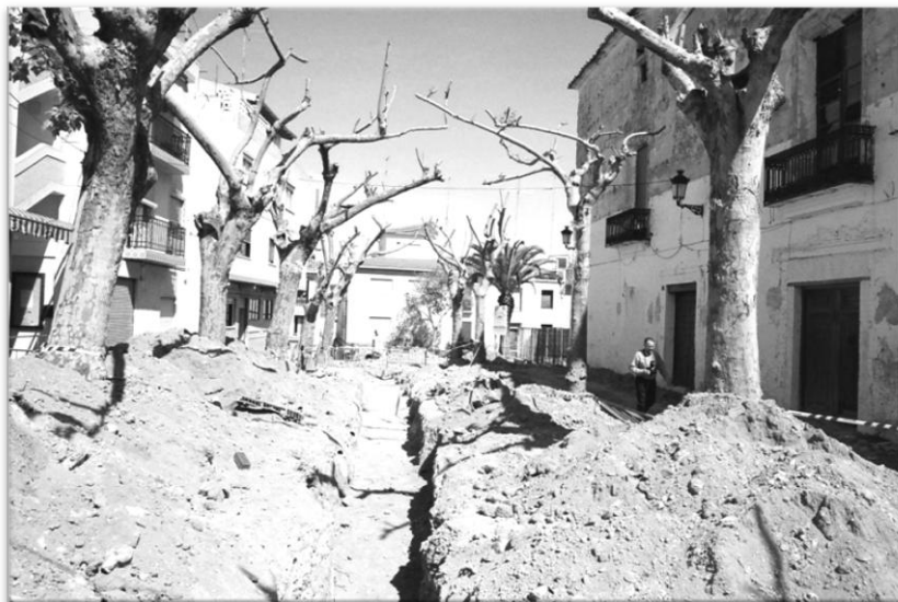
Palacio de los Cervellón en la Alameda. Rehabilitación de la conducción de agua desde la balsa de Arriba.
