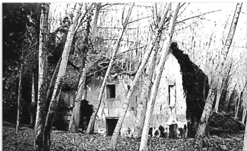
Central eléctrica de la Compañía Trénor meses antes de su desaparición en la década de los noventa del siglo XX. Foto José izquierdo.
