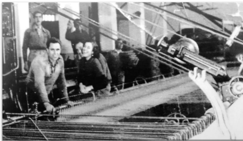
Maquinaria y trabajos en la fábrica de Miguelín. Fotos archivo José izquierdo.
