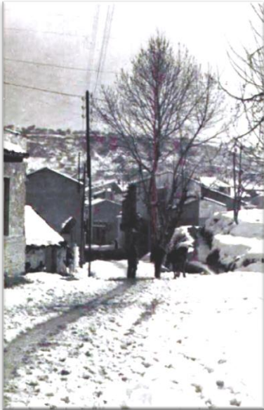
Canal del "Siprer" en la entrada del pueblo.
